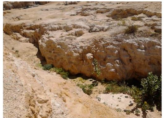
A long terme, ces petites excavations (car il s'agit d'une carrière de ramassage et l'extraction de blocs de roche laisse des calottes) constitueront un danger pour les exploitants et les riverains et donnent naissance à plus d'érosion.
