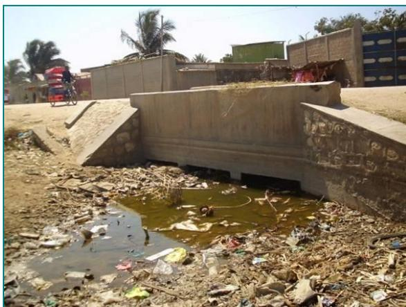
Sortie d'un dalot bouché à cause des déchets : le dalot en question n'est plus fonctionnel
