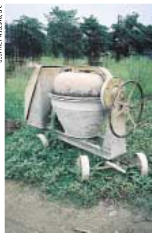
Заброшенная стройплощадка в Таиланде. Одинокaя бетономешалка ждет лучших времен — когда в страну станут возвращаться капиталы.
