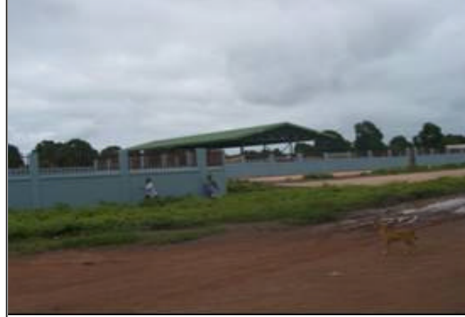
Marche Missira - Hangar et Enceinte
