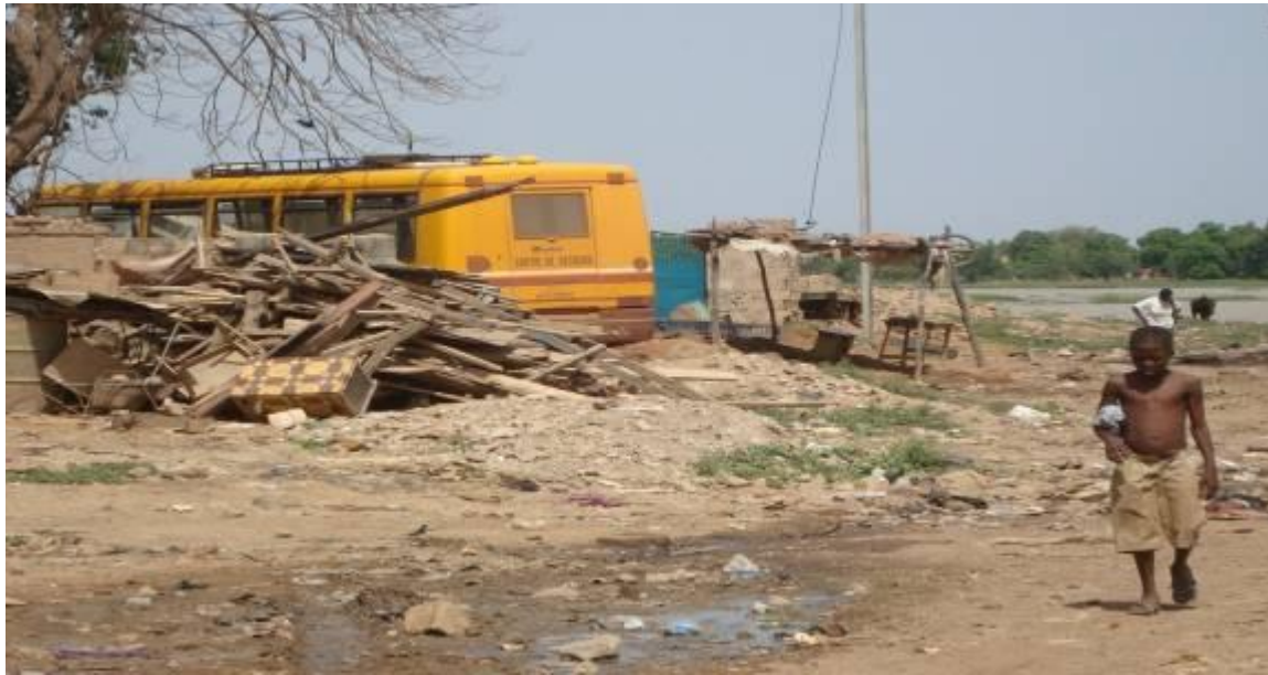
Figure 18 : Habitat complètement détruit lors des inondations de 2009
