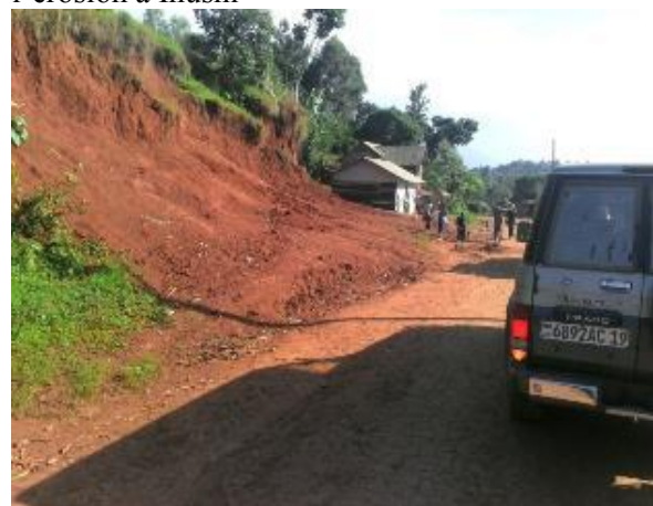
Photo 10 : Habitat menacé par l'effet de l'érosion à Ihushi
