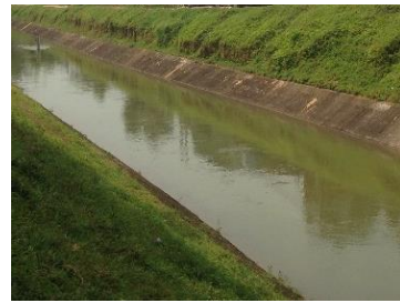
Ho Nui Coc diversion canal (item 4)
