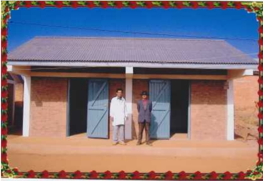
Photo 2 : Nouveau centre de santé réalisé par FDL à Ankarahara
