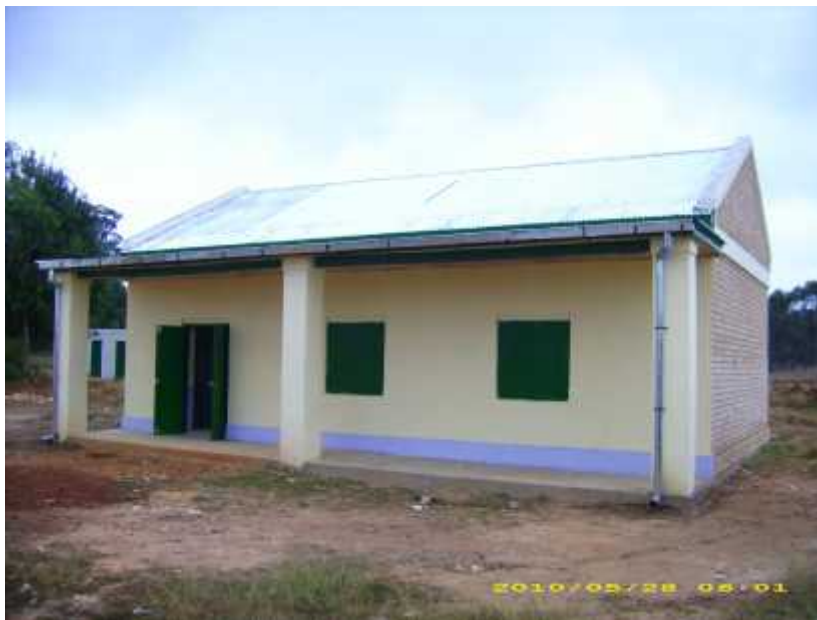
Photo 1 : Nouvelle école réalisée par FDL à Ambolomadinika
