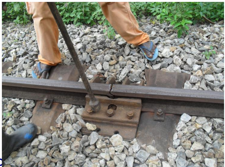
Photo N°21: Vue des agents en action d'entretien de rails cassés
