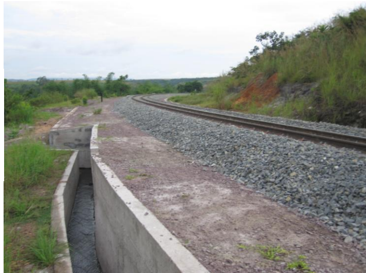
Photo N°23: Vue de la voie contournée pour éviter les inondations de la rivière Djoué près de la gare de Kiéllé Tenard
