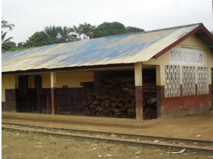
Photo N°7: Vue de la gare de Mossendjo sur la ligne ex COMILOG
