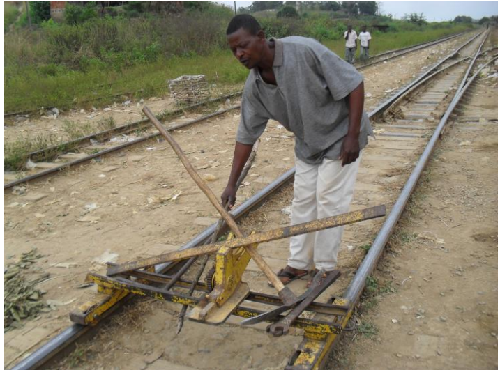
Photo N°19: Vue de quelques matériels d'entretien des voies ferrées
