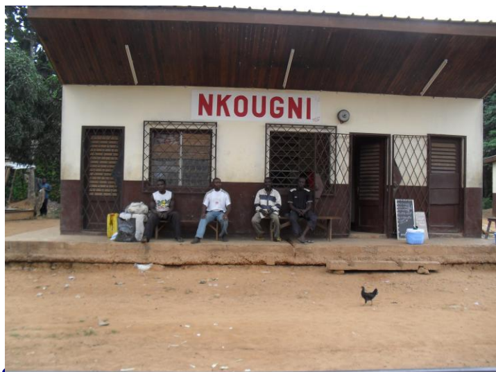
Photo N°6 : Vue de la gare de NKougni sur la ligne principale Pointe Noire - Brazzaville (réalignement)
