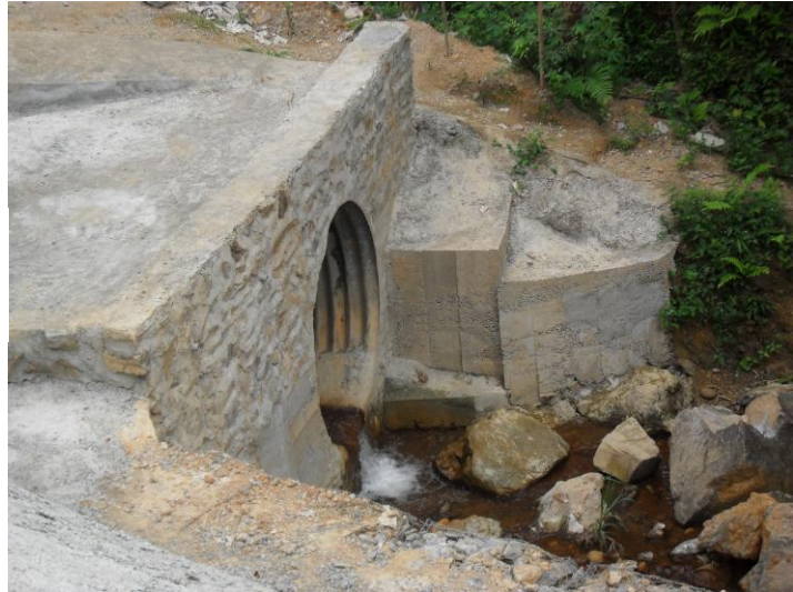
Photo N°22: Vue d'un ouvrage réhabilité sur la ligne du réalignement
