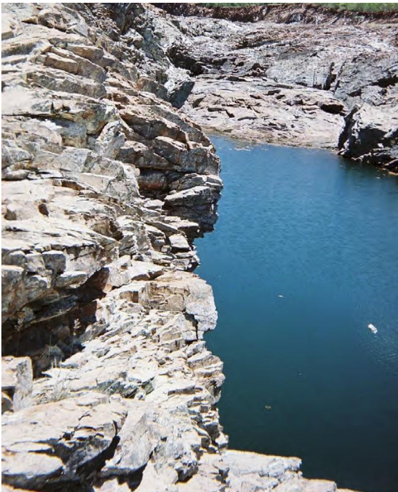
Muzhwi: Spillway return channel
