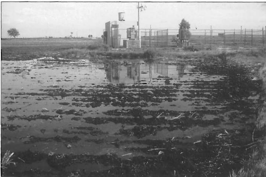
b) zona operacional del pozo dimensionada y protegida en forma inadecuada, amenazada por riego agrícola con aguas residuales urbanas
