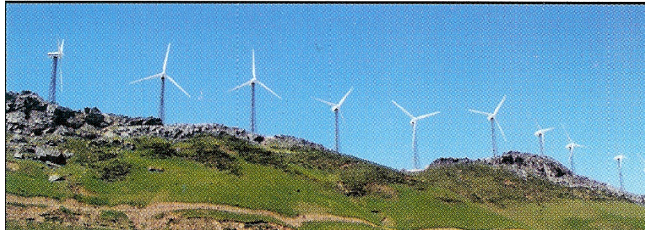
Figure 11: Parc éolien A. Torres, 50,4MW
