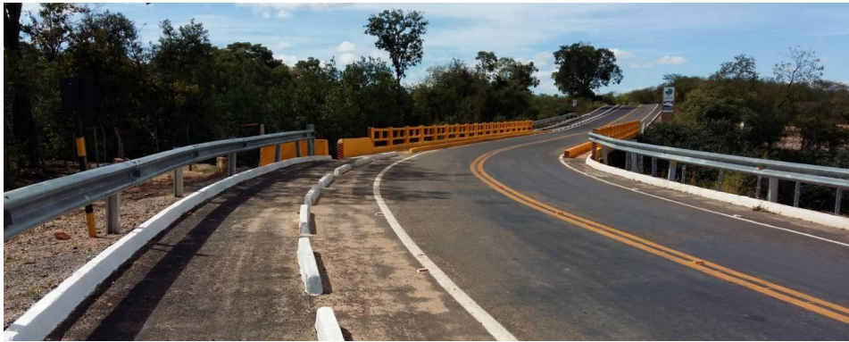
Pavement of the Cachoeira Road in Missão Velha
