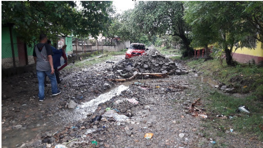
Figura 7. Estado precario de calles, situación general en la Colonia Roberto Suazo Córdova.
