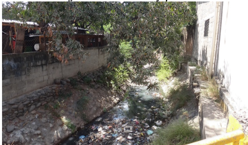
Figura 3. Cuneta de drenaje pluvial.
