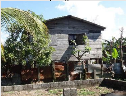
Vivienda con piso, paredes y techo con materiales de madera y/o lámina galvanizada
