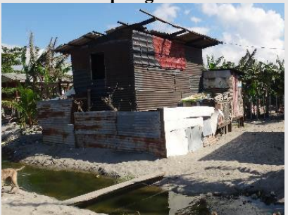
Vivienda con piso, paredes y techo con materiales precarios
